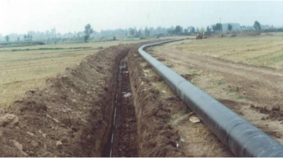
图 1.4-2 管沟开挖及布管实景
