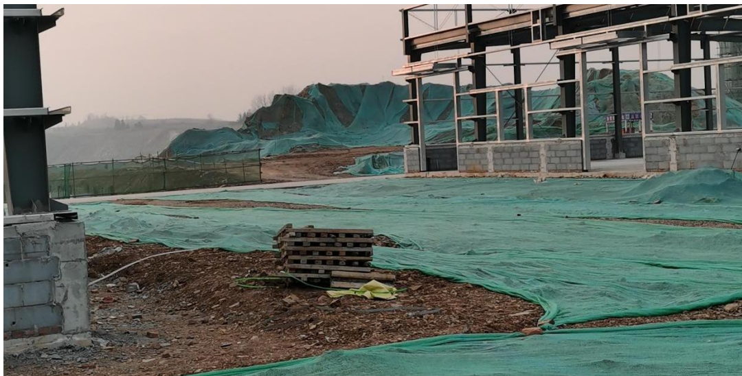
项目区临时防尘网覆盖
