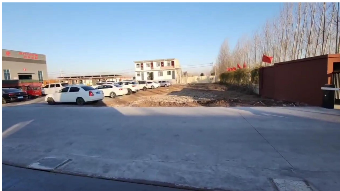
办公楼整平后建设前现状（2024.12.15）
