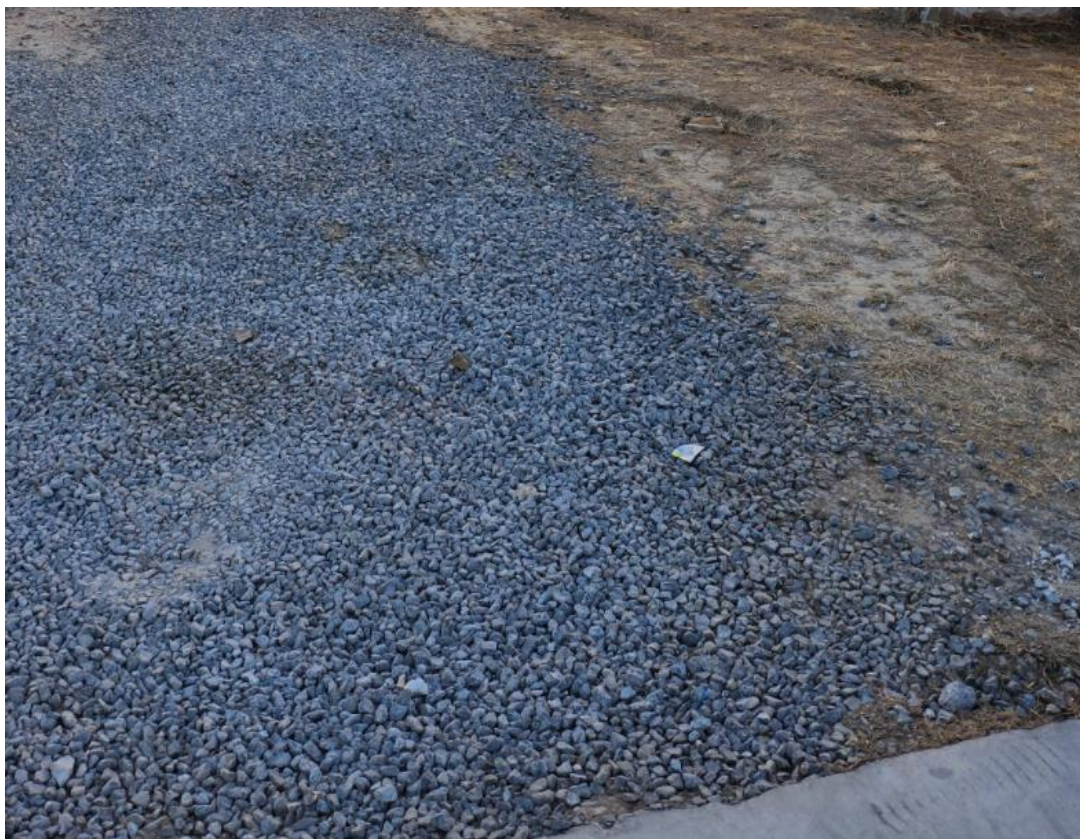
碎石压盖现状（2024.12.15）
