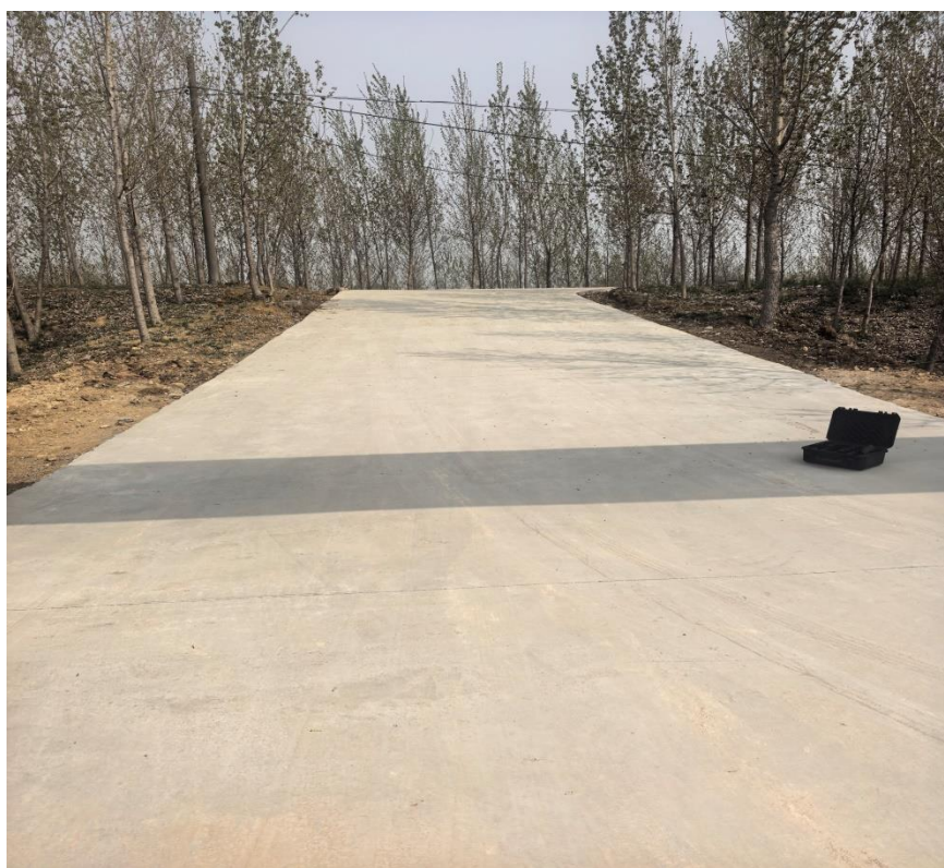
已有进场道路现状（原工厂遗留道路）（2025.3）
