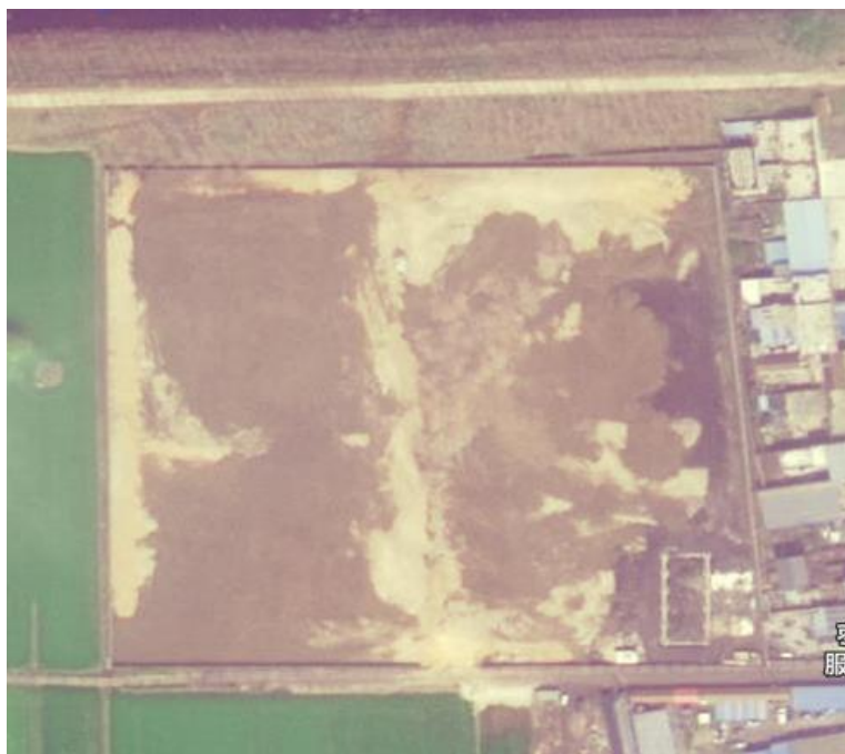
储能及变电站区拿地时影像资料—净地（2024.1）
