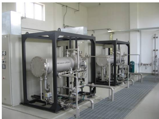
臭氧发生器及液氧储罐图片
