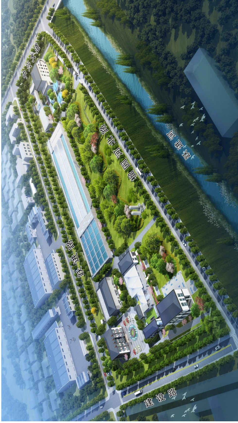
枣庄市峄城区污水处理厂（扩建厂）提标改造工程 鸟瞰图
