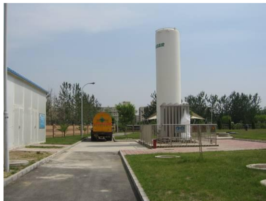
臭氧发生器及液氧储罐图片
