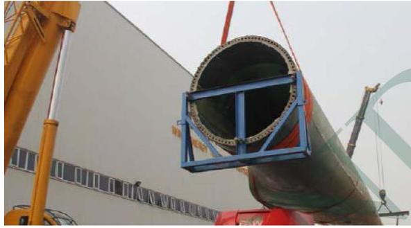
图 2-9 本项目叶片吊卸图
