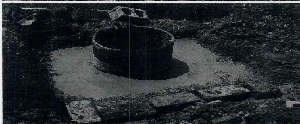
检查井维修中
