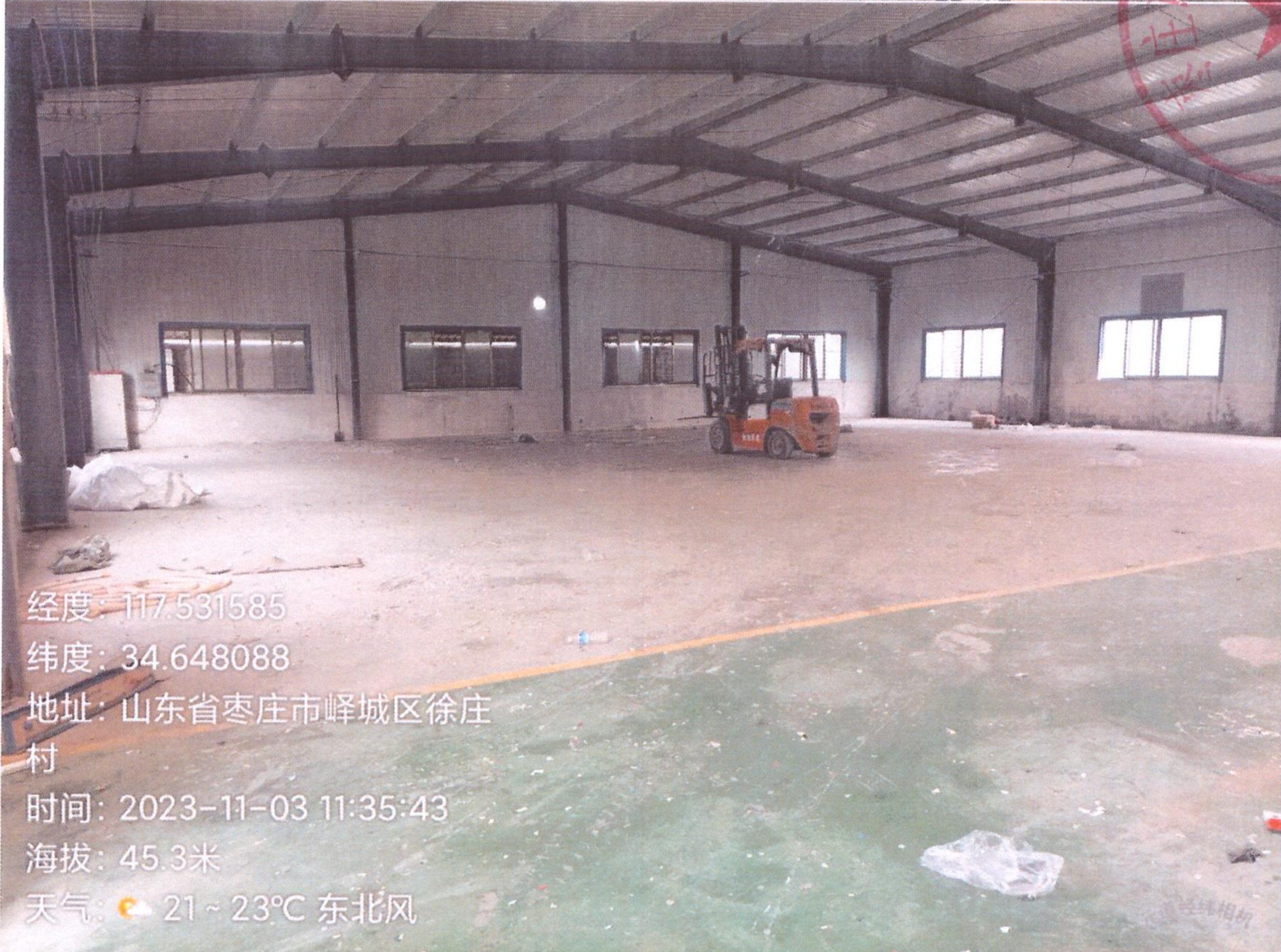
整改后现场照片
