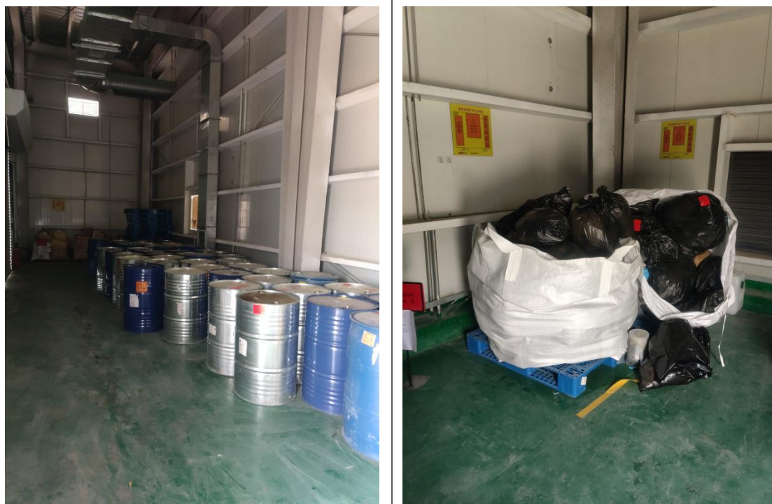
图 2.2-7 危废间无集液池、导流槽
