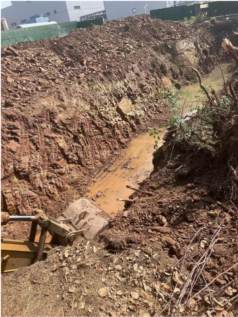
图 3.3-7 建设单位周边现场土壤挖掘图
