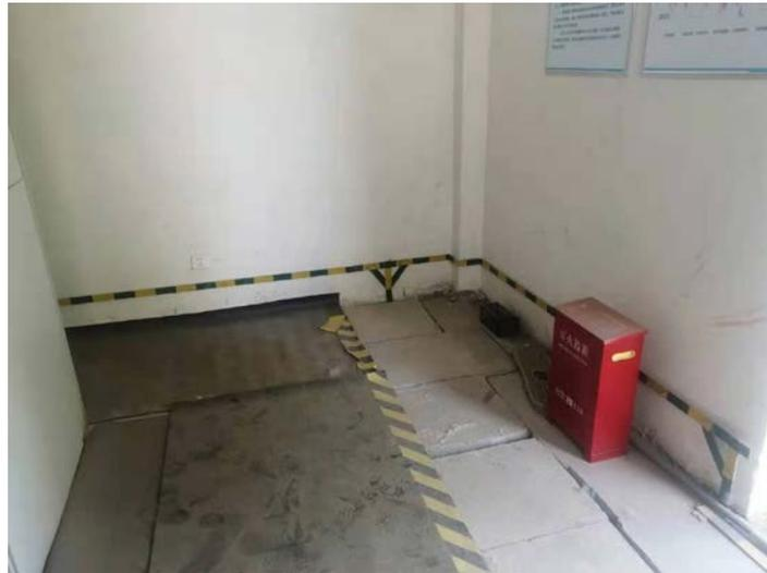
图 3-25 电力接地及安全系统
