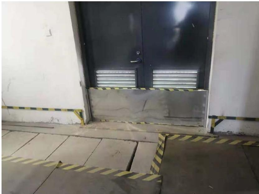
图 3-11 建筑物防鼠挡板
