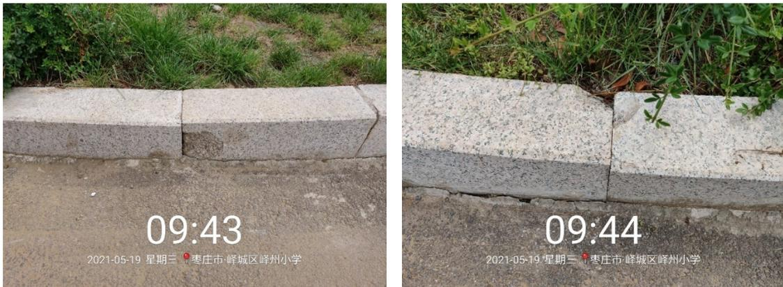
图 3-16 路缘石破损情况
