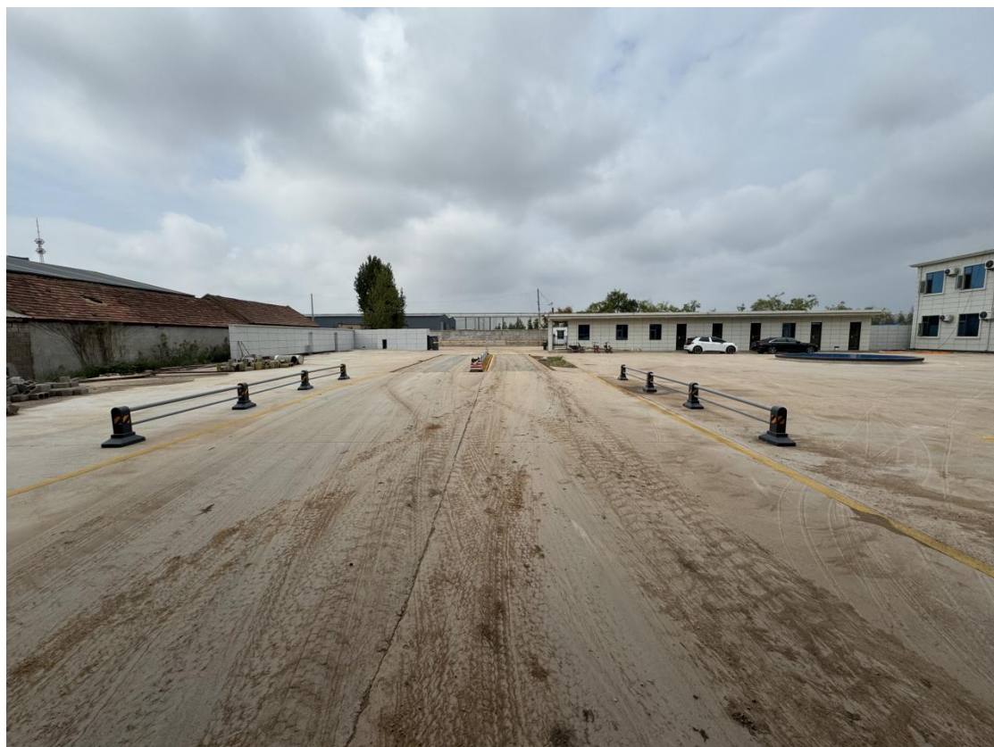
厂区厂房及设施现状
